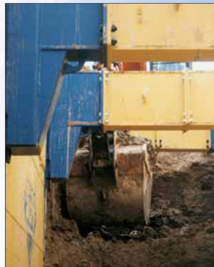
Надежная конструкция роликовой распорки не подвержена перекосам даже при использовании в траншеях большой ширины. Значительные усилия сжатия передаются на соединительные перекладины, прогиб которых очень мал. Большие моменты в углах рамы, возникающие при одностороннем нагружении в процессе опускания крепи, значительно лучше воспринимаются роликовыми распорками.
